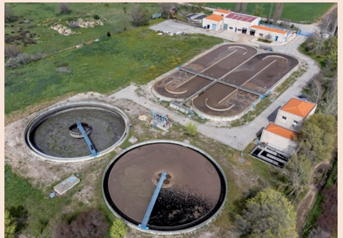
Vista aérea de la Estación Depuradora de Aguas Residuales
