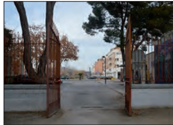
Imagen de la zona, una vez finalizadas las obras
