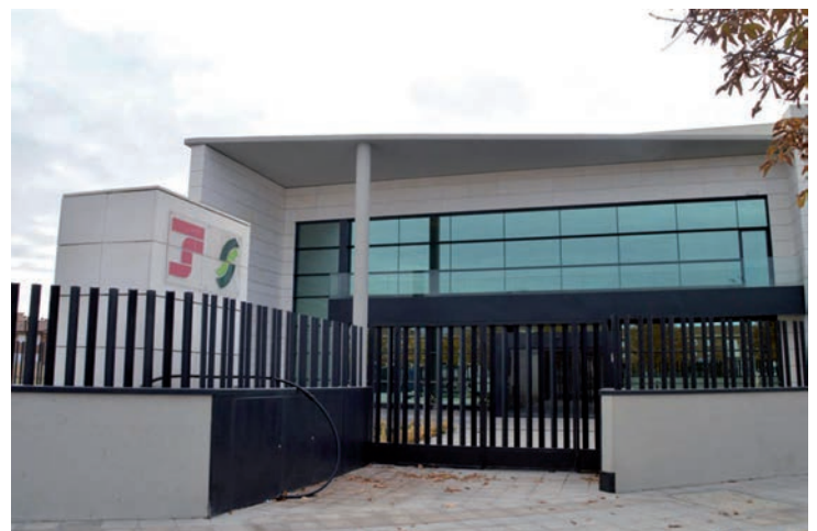
Exterior del edificio, cuya puesta en funcionamiento viene reclamando desde hace años el Ayuntamiento
