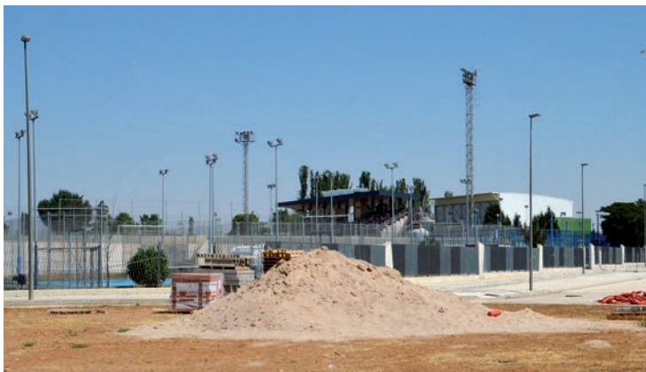
Trabajos en el sector SUR R6
